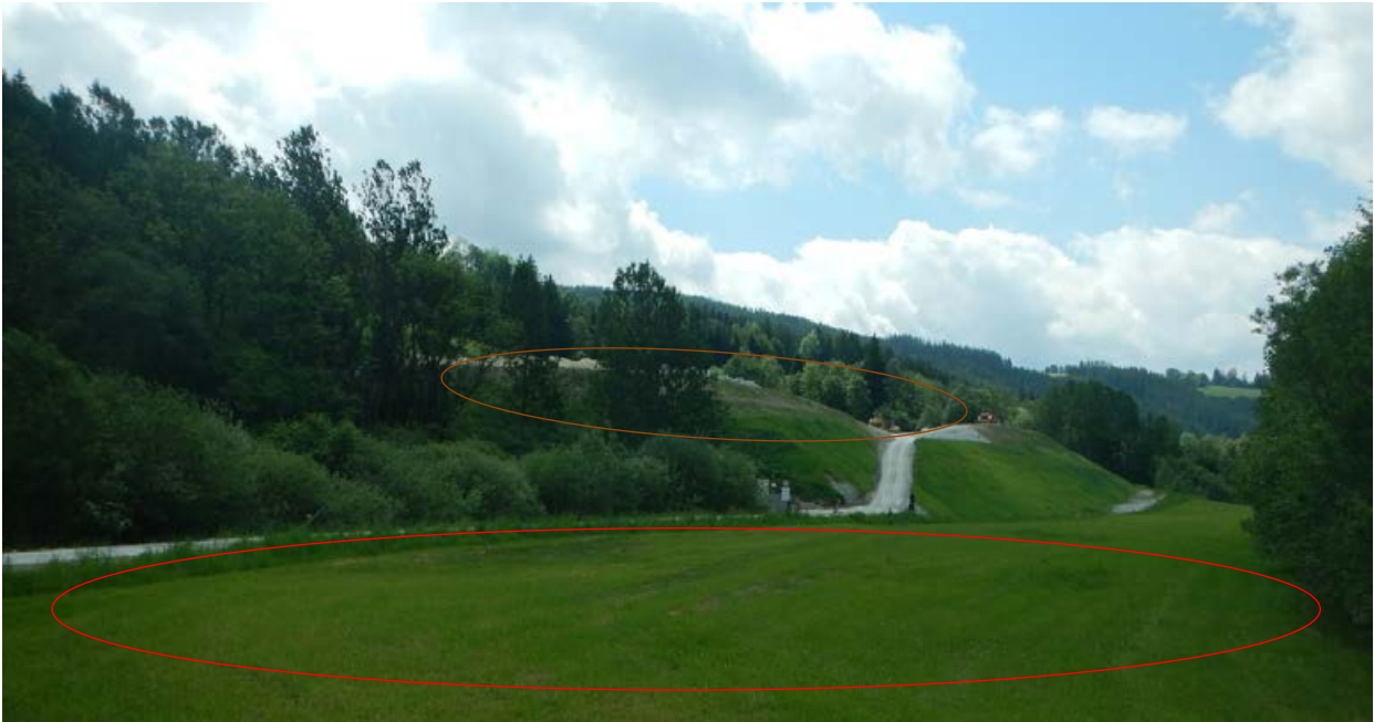
E4 + P1 - Blick von der Baustellengeländezufahrtsstraße Richtung Südwesten auf die Aufschüttungsfläche (P1)
