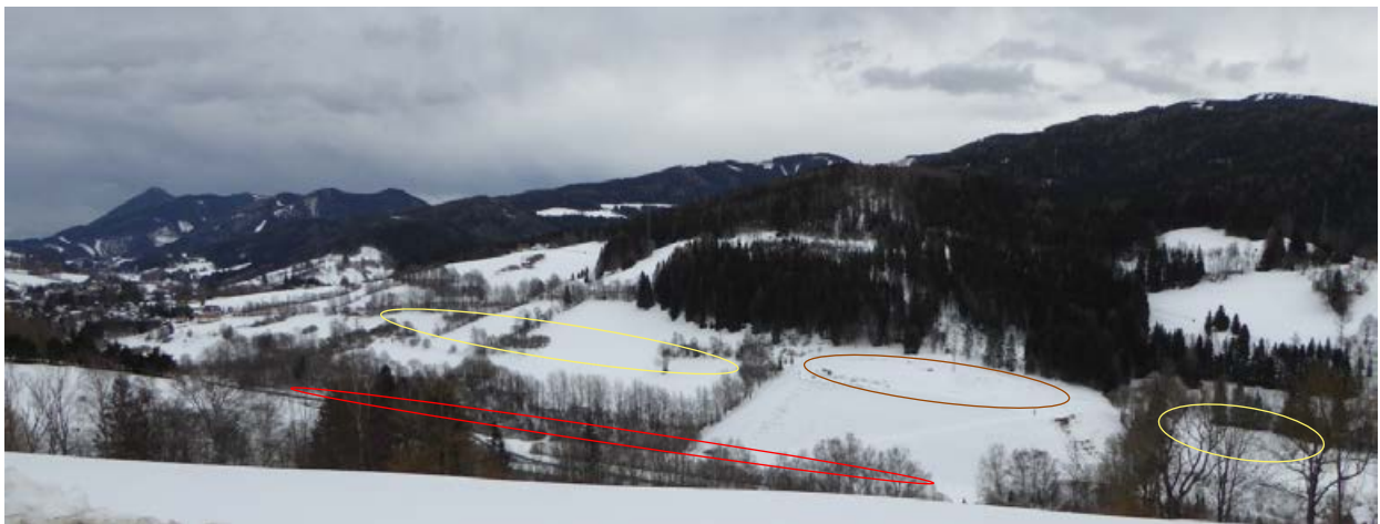
E4, P1 und A2 - Blick vom Gegenhang Richtung Südosten
