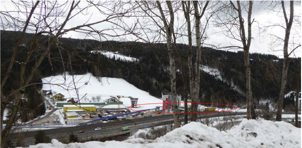
E3 - Blick vom Gegenhang auf die Semmering-Basistunnel Baustelle Grautschendorf
