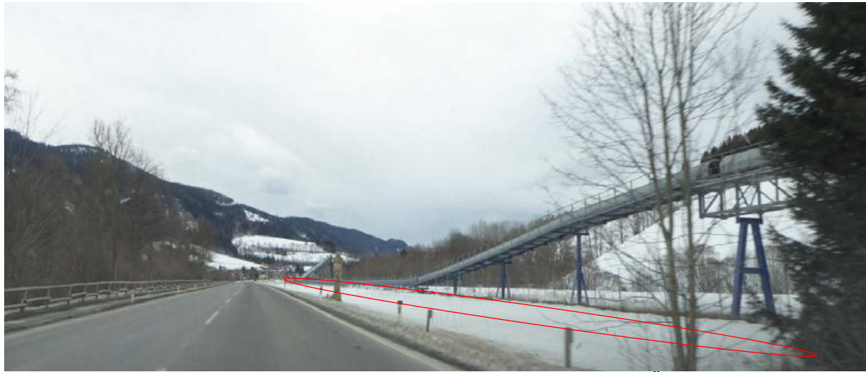
E4 - Blick von der L118 auf den östlichen Teil, im Hintergrund Teile der ÖBB-Tunnelbaustelle Grautschenhof
