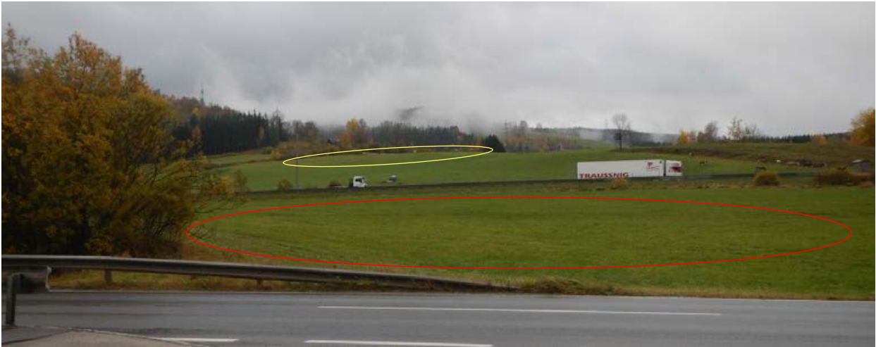
E1 und A1 - Blick von der L118 Richtung Süden auf die S6
